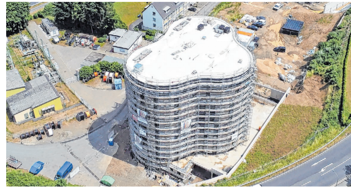
Als Generalunternehmer realisiert ZENZ-Massivhaus für die LEPPER-Stiftung derzeit die Junior Uni Daun. Foto: ZENZ-Massivhaus
